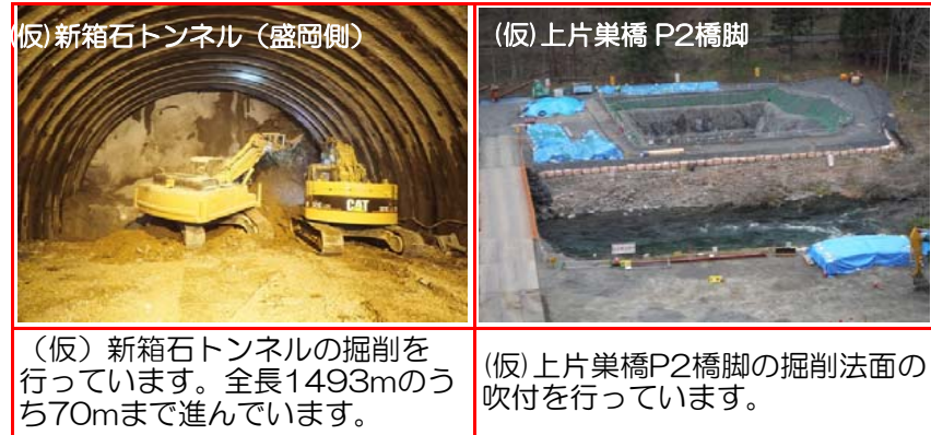
⑥施工：安藤・間
